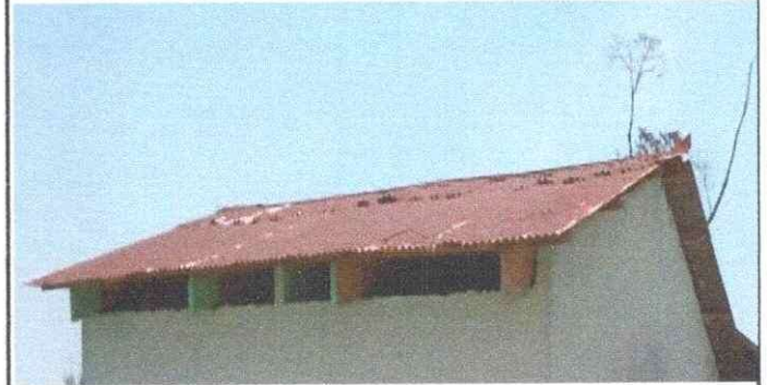
Foto 2: SE OBSERVA LAS LAMINAS PORTANTES DEL MODULO 2,
